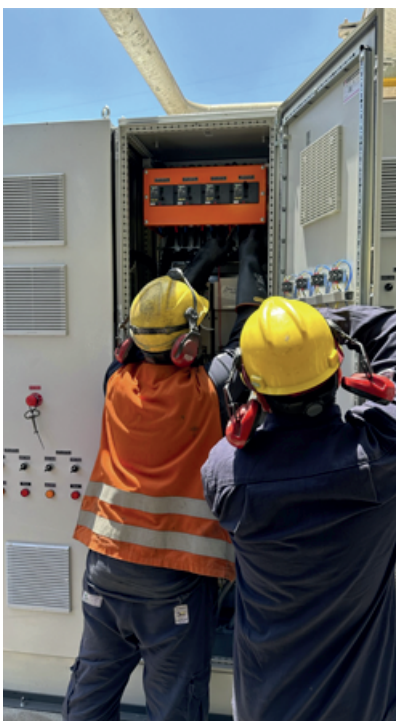
Transformadores de potencia
